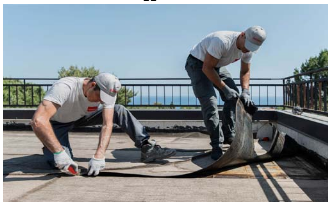
5 - Pulizia e preparazione supporto
