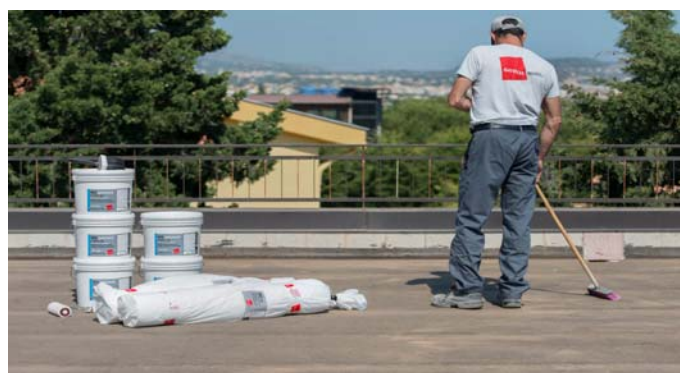
4 - Pulizia e preparazione supporto
