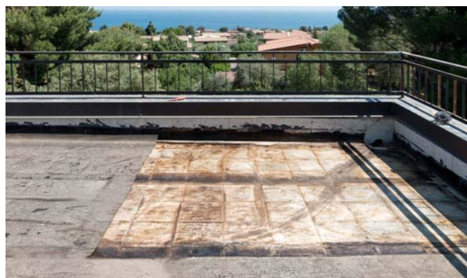
6 - Pulizia e preparazione supporto
