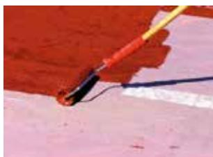
**CAMPO D'IMPIEGO** WG-armatura consente l'armatura di impermeabilizzazioni di terrazze, solette, coperture piane, ondulate e grecate sia orizzontali che verticali.
