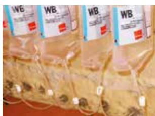
**CAMPO D'IMPIEGO** Si usa per un utilizzo ottimale di WB-barrier, barriera chimica liquida antiumido. Consente l'iniezione del prodotto nelle murature soggette all'azione dell'umidità di risalita.
