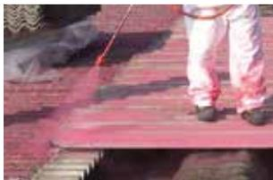
**CAMPO D'IMPIEGO** Per la preparazione di lastre in cemento amianto, eternit ed altri manufatti contenenti amianto prima delle operazioni di rimozione. Consente di effettuare le fasi di smontaggio, manipolazione e trasporto in discarica operando in sicurezza.
