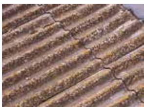
**CAMPO D'IMPIEGO** Penetra, consolida e prepara superfici murarie di qualsiasi tipo anche se sfarinanti come fibrocemento, calcestruzzo, gesso, vecchi intonaci, cemento amianto (abbinato a WG-G è idoneo e certificato per l'incapsulamento, secondo la norma UNI 10686).
