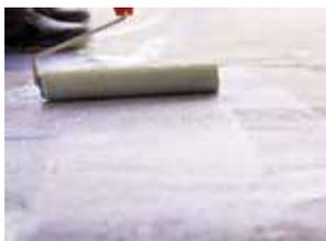
**CAMPO D'IMPIEGO** Penetra, consolida e prepara superfici di qualsiasi tipo prima dell'utilizzo di impermeabilizzanti poliuretani o acrilici. PR-epoxene si usa su massetti cementizi, piastrelle in cemento, calcestruzzo, ceramica, superfici bituminose, vecchi trattamenti impermeabilizzanti, metallo, legno, vetro. Può anche essere usato come finitura consolidante per il trattamento di pavimenti in cemento all'interno.
