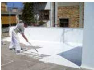
**CAMPO D'IMPIEGO** Impermeabilizza superfici murarie sia rifinite che grezze, intonaci, calcestruzzo, mattoni, cemento, calce, terrazze grezze o pavimentate, coperture di capannoni, lamiera zincata, fibrocemento e simili.
