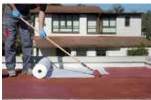
**CAMPO D'IMPIEGO** Tetti, terrazzi, coperture, muri controterra, bagni, piscine, superfici sottoposte ad assestamenti o deformazione. WG-tex viene inserito all'interno di impermeabilizzanti liquidi come WG-G (guaina acrilica), WG-acquastop (elasto-membrana sottopiastrella), WG-cem PLUS (elasto-cementizia), WG-SP, WG-therm o similari. Idonea per riparare le crepe del cemento-amianto (ciclo incapsulamento WG-G, UNI 10686 A-B-C).
