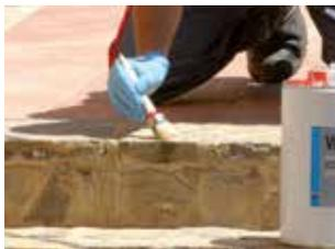
**CAMPO D'IMPIEGO** Su tetti, terrazzi, pavimenti, cemento e tutte le superfici porose soggette all'azione degli agenti atmosferici. Si usa anche su vecchie pavimentazioni di garage, viottoli, gradini, marciapiedi come protettivo-consolidante-antipolvere. Usato come finitura sulle guaine liquide ne aumenta la calpestabilità e la resistenza all'abrasione.
