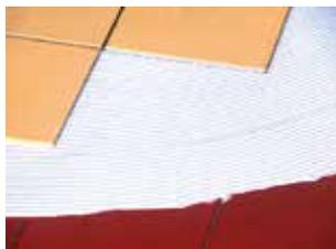
**CAMPO D'IMPIEGO** Si usa per la posa di pavimenti, rivestimenti e mosaici in ceramica, gres, klinker, marmo, pietra. Idoneo anche per applicazioni su legno, derivati del legno, ceramica, gres, cartongesso, fibrocemento o supporti deformabili (pannelli in legno truciolare, multistrato, etc.). AS-G8 grazie alla sua lavorabilità ed al suo elevato tempo di agglustabilità è indicato per la posa di mosaici, pietre naturali, decori e simili.
