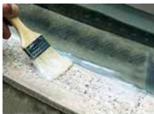
**CAMPO D'IMPIEGO** Si usa su tetti, terrazzi grezzi o pavimentati, coperture, tettoie, muri, massetti, cemento, intonaci, legno, lamiera, PVC rigido, grondaie, fioriere, superfici con geometrie irregolari. Specifico per la realizzazione di impermeabilizzazioni sigillanti invisibili.
