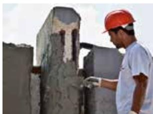
**CAMPO D'IMPIEGO** Si usa per diverse applicazioni: riprese di getto, finiture di edifici, restauri in genere, pavimentazioni, livellamenti, massetti, sigillature di giunti rigidi, massetti per pavimenti radianti, boiacche ed intonaci in cemento, ripristino di parti mancanti su strutture degradate, aumento dell'adesività di colle cementizie, ed in tutte le situazioni in cui occorrono malte con elevate prestazioni.
